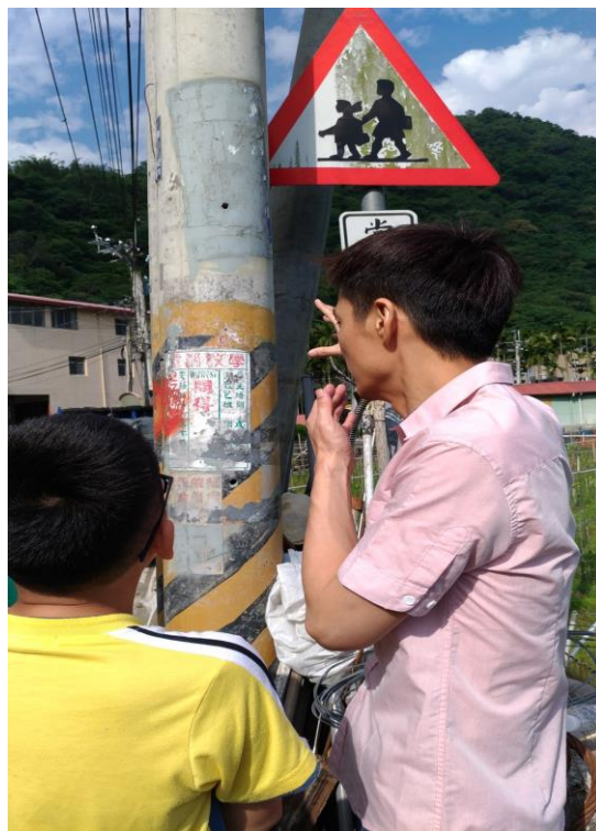
設置交通安全標誌、標線、號誌等交通設施
