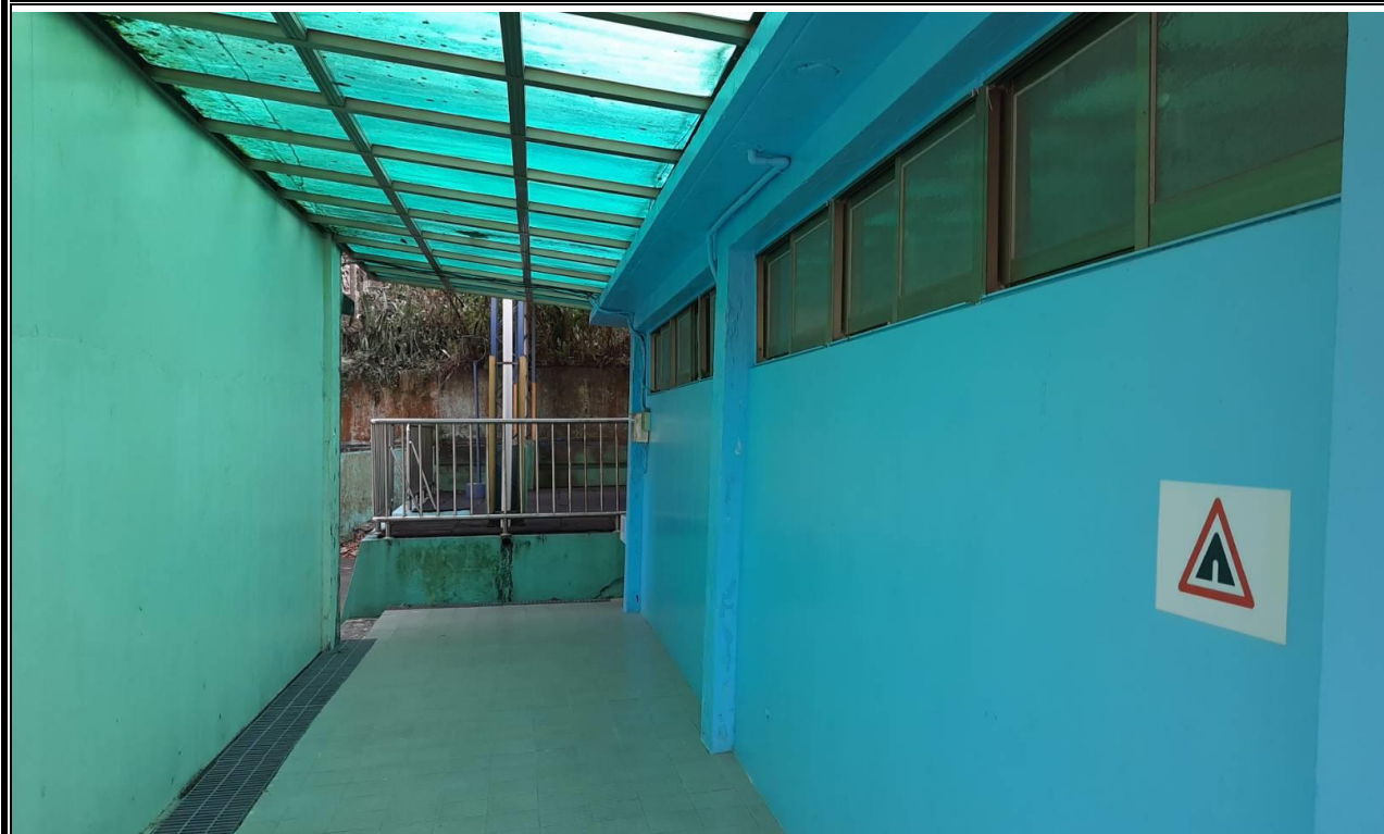
配合學校地形地物設置交通安全標誌—隧道
